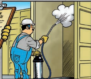
Odformovací nátěr naneste v tenké a rovnoměrné vrstvě.
