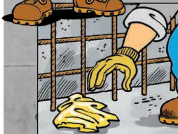
Odstraň všechny nečistoty a smetí z bednění.
