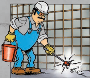
Vyčisti bednění (vysavačem, magnetem).
